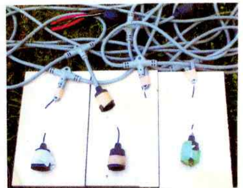
破損部分の切断・・・
